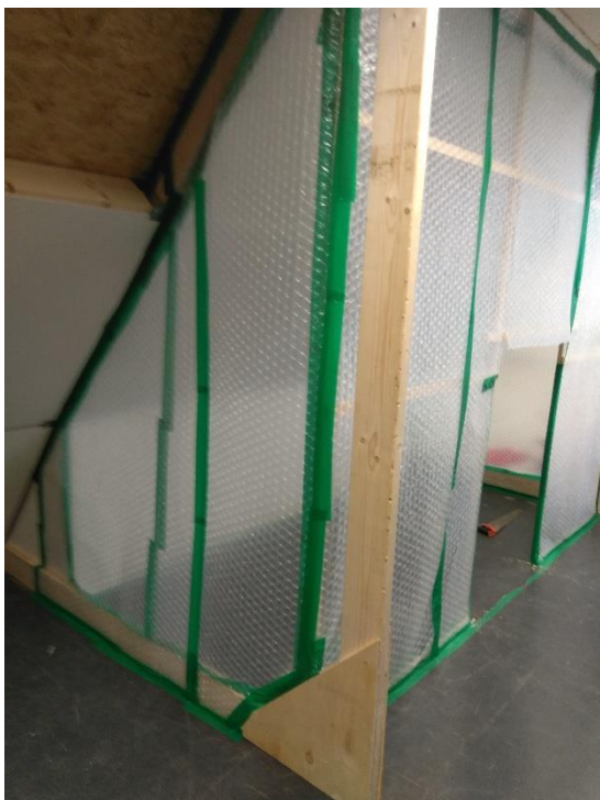
Figuur 2: Buitenzijde proefopstelling
